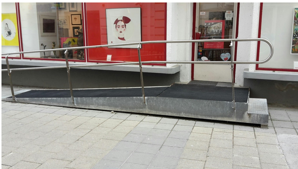
Abbildung 4 Rampenkonstruktion über 2 Stufen, St. Pölten Innenstadt 2019 © ÖZIV ACCESS
