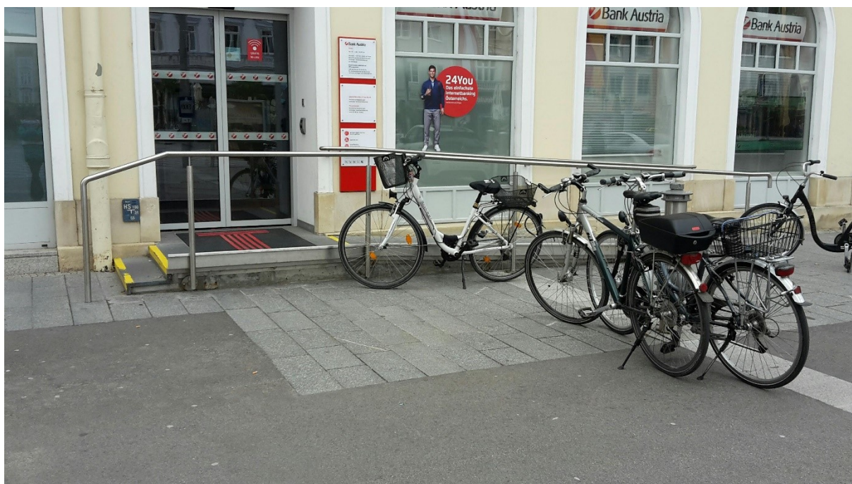
Abbildung 3 Rampenkonstruktion über 2 Stufen, St. Pölten Innenstadt 2019 © ÖZIV ACCESS
