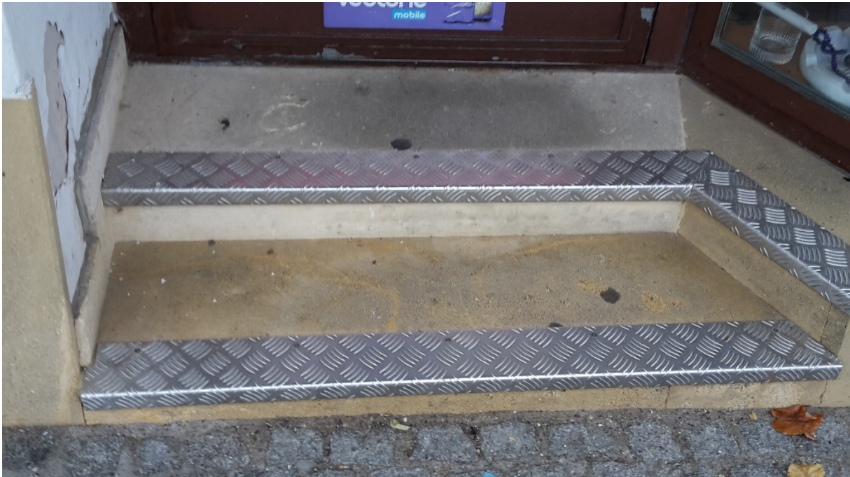
Abbildung 1 Geschäftslokal mit 2 Stufen, Eisenstadt Innenstadt 2019 © ÖZIV ACCESS
